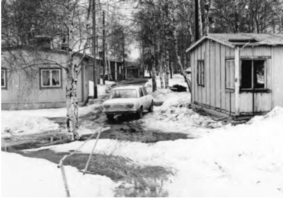
Kuva 5. Vaakunakylä vuonna 1981 (kuva: Pohjamo 2011, 181. Kuva alun perin Pirkko Kingelinin vuoden 1981 harjoitustyöstä).
